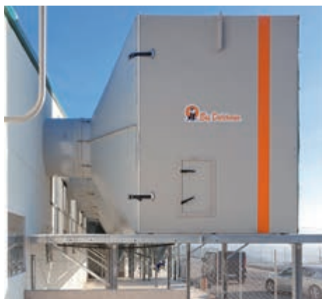
Установка на центральну систему подачі припливного повітря
